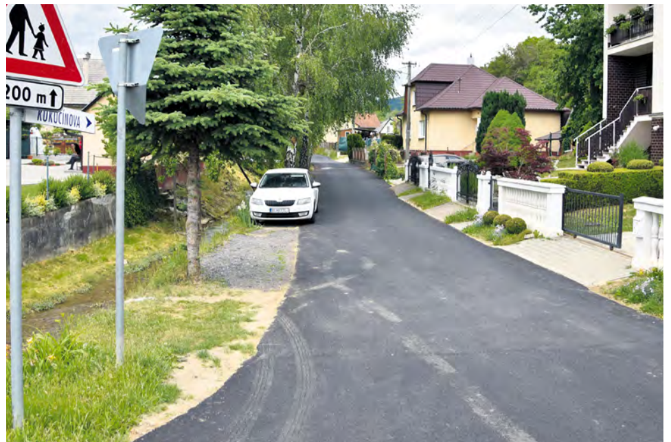
Kukučínova ulica po rekonštrukcii
