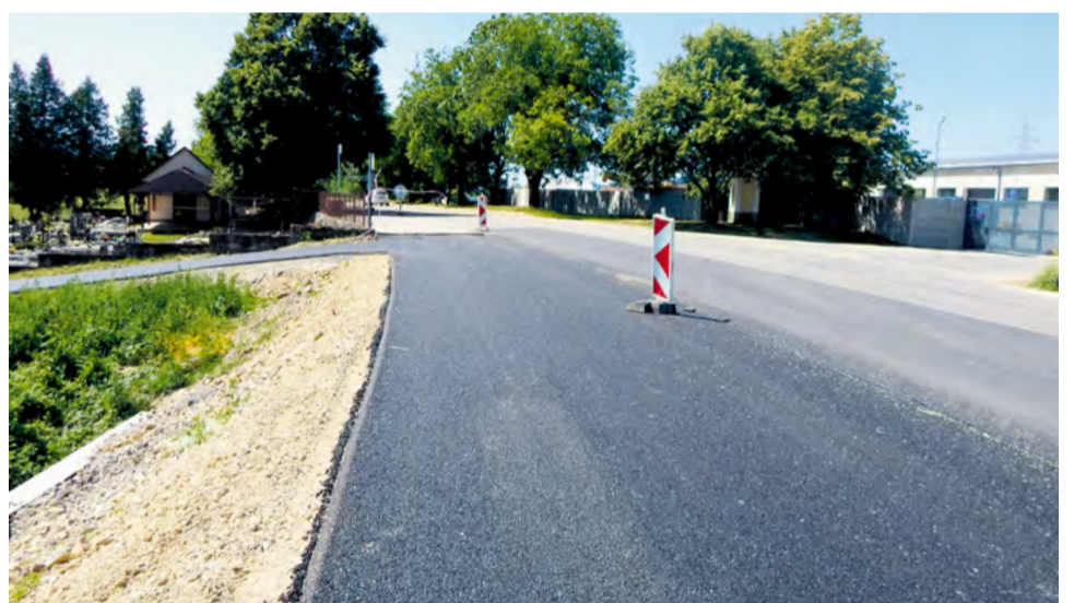
Nový asfaltový povrch na cyklochodníku Ľuborča – Klúčové
