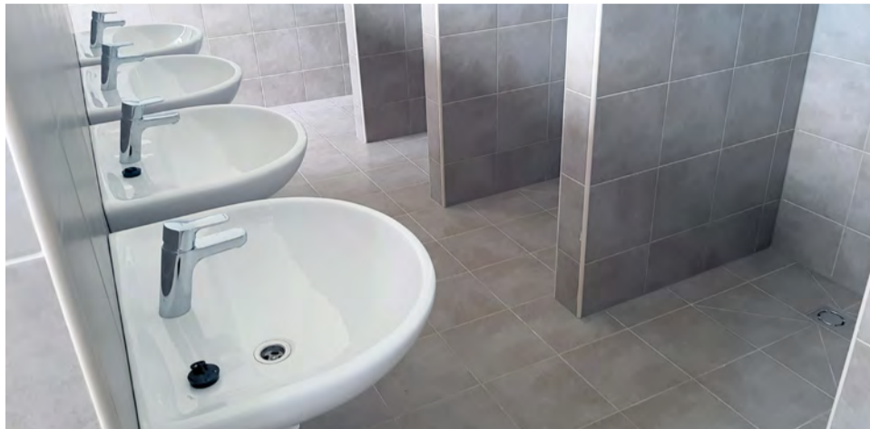
Zrekonštruované sociálne zariadenia v športovej hale
