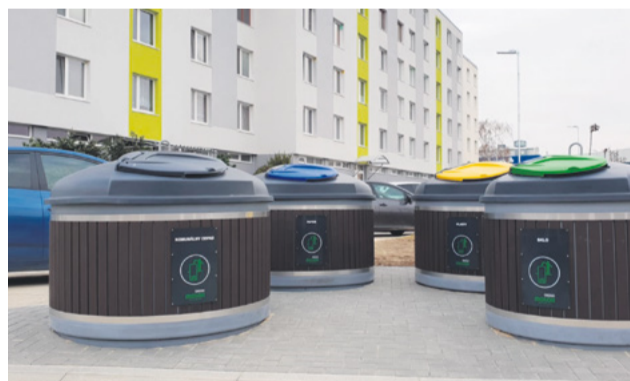
Osadenie separačných polopodzemných kontajnerov
