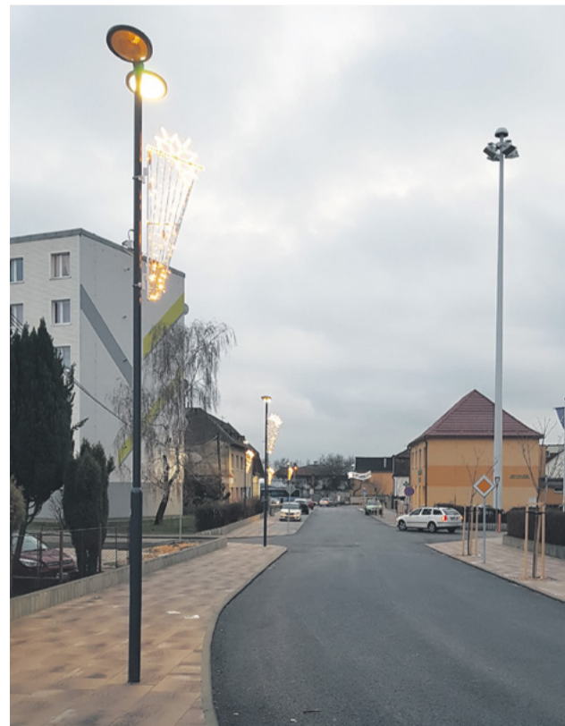
Nový asfaltový koberec, chodníky i osvetlenie na Železničnej ulici
